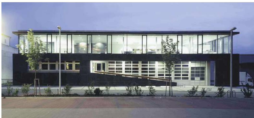
Passt zur Firmenkultur: Auch das neue Verwaltungsgebäude der Firma Westermann vermittelt Offenheit und Transparenz
